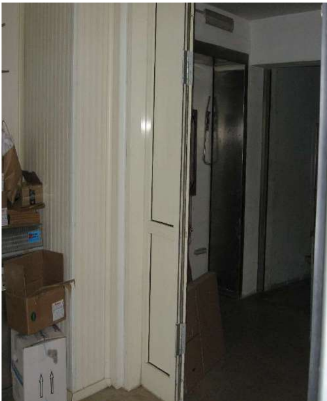
FOTOGRAFIA N° 75 Vano n° 24 - Atrio
