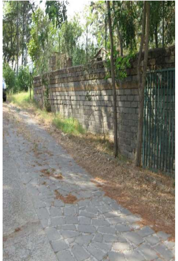
FOTOGRAFIA N° 134 AREA CIRCOSTANTE – 2° INGRESSO
