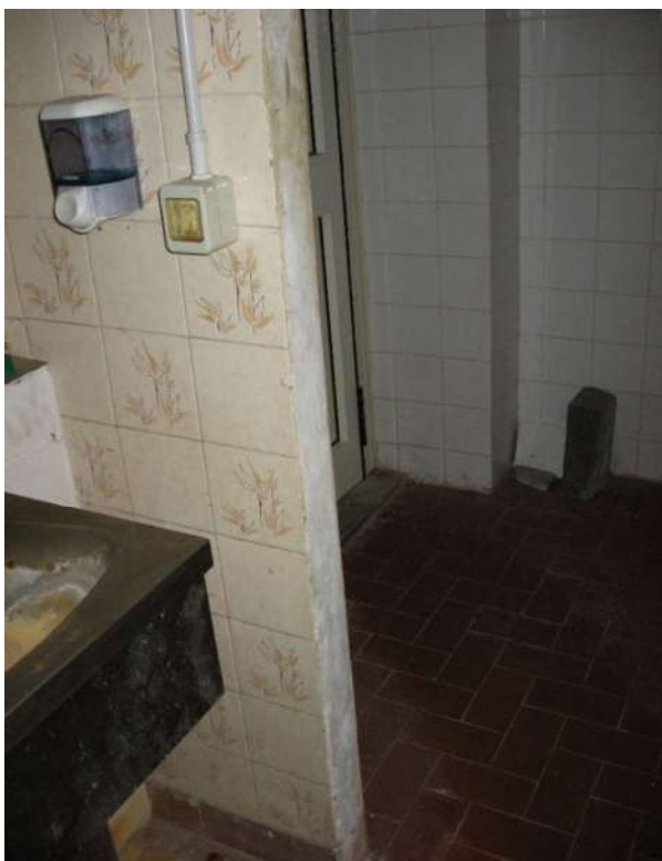
FOTOGRAFIA N° 83 Vano n° 23- W.C.
