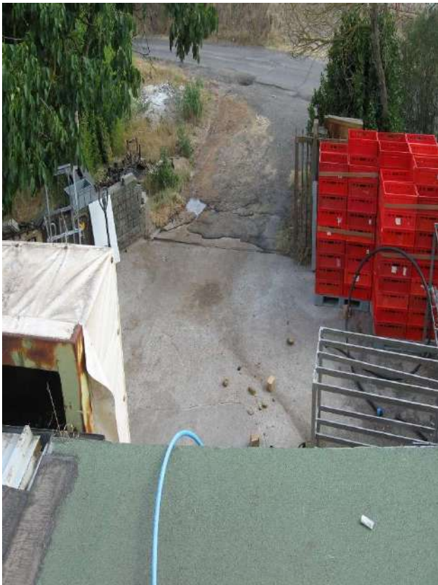
FOTOGRAFIA N° 135 AREA CIRCOSTANTE – 3° INGRESSO
