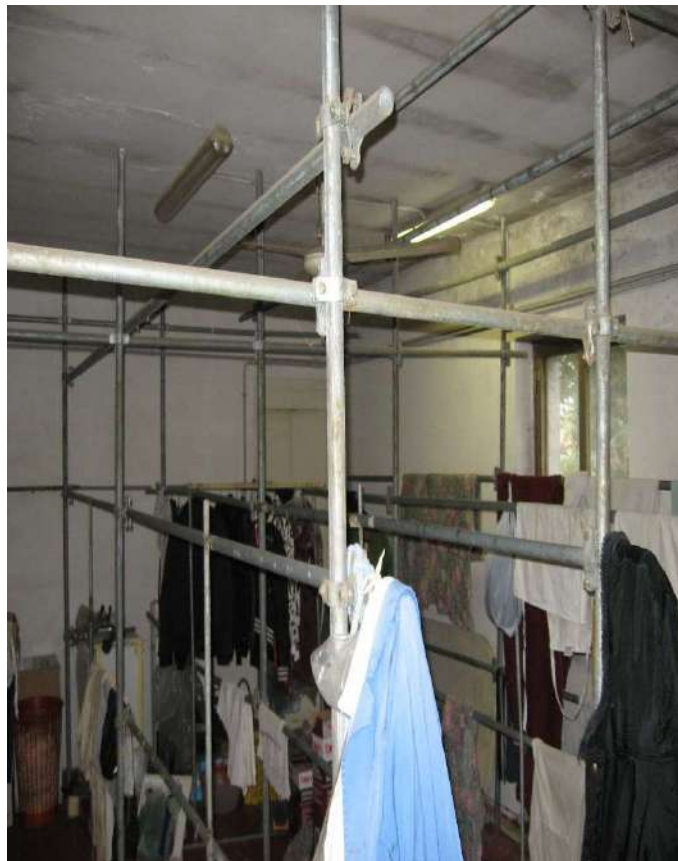
FOTOGRAFIA N° 50 Vano n° 27 – Loc. deposito
