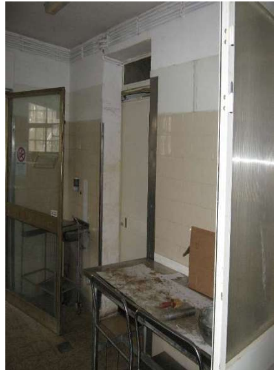
FOTOGRAFIA N° 96 Vano n° 12 – Loc. stag. ventilata
