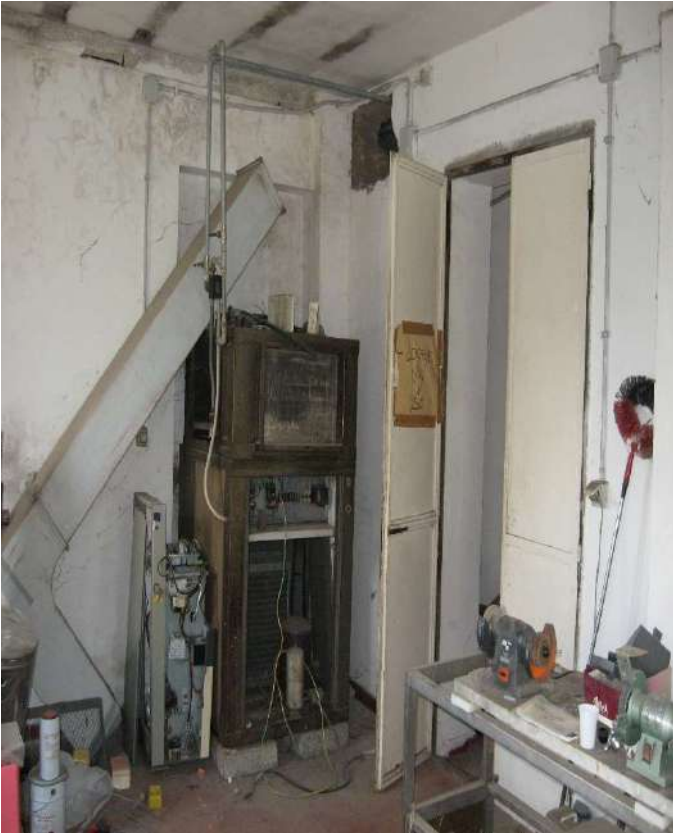
FOTOGRAFIA N° 61 Vano n° 36 – Essiccatoio
