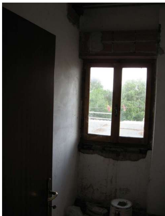
FOTOGRAFIA N° 56 Vano n° 31 - W.C
