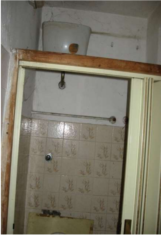
FOTOGRAFIA N° 85 Vano n° 23- W.C.
