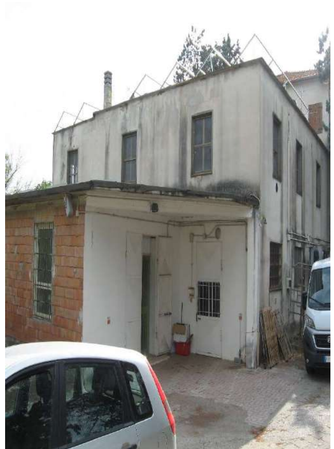
FOTOGRAFIA N° 8 Lotto circostante la palazzina-Prospetto A - D
