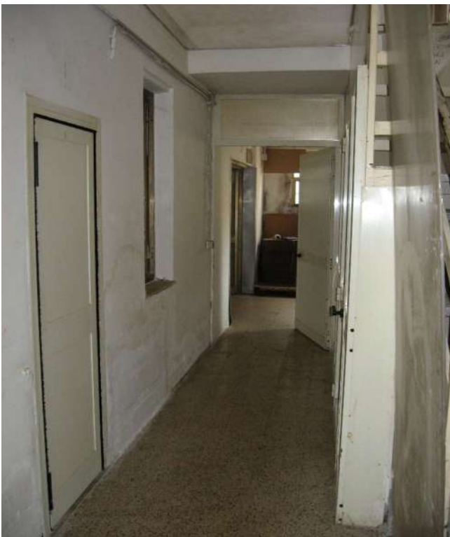
FOTOGRAFIA N° 79 Vano n° 24 - Atrio
