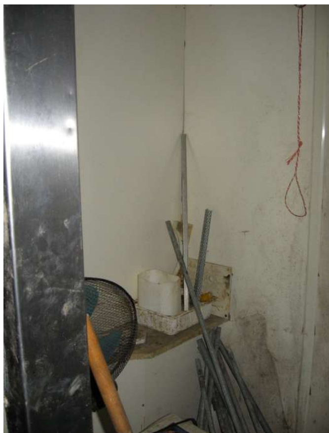
FOTOGRAFIA N° 101 Vano n° 9 – Loc. deposito
