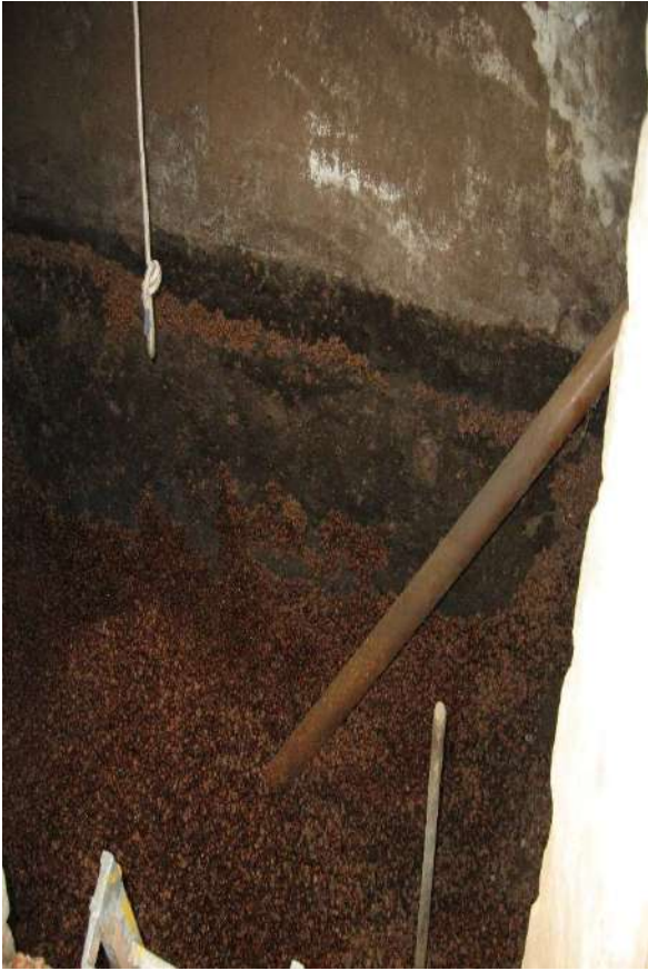
FOTOGRAFIA N° 121 Vano n° 26 locale deposito
