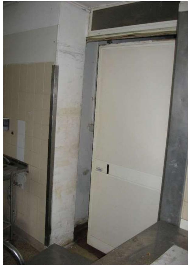
FOTOGRAFIA N° 90 Vano n° 13 – Loc. stag. ventilata
