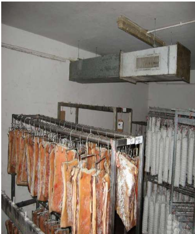
FOTOGRAFIA N° 91 Vano n° 13 – Loc. stag. ventilata
