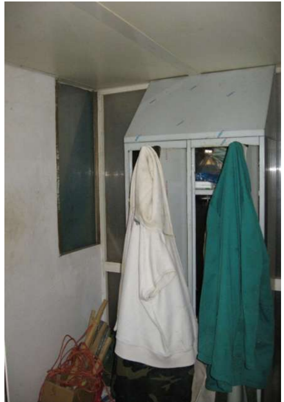
FOTOGRAFIA N°86 Vano n°22 - Spogliatoio
