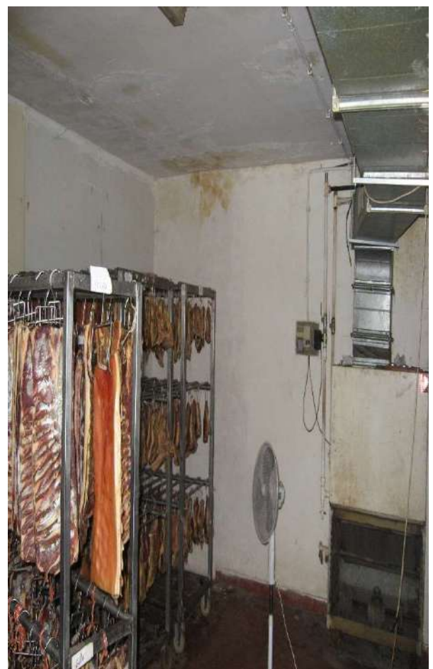
FOTOGRAFIA N° 94 Vano n° 13 – Loc. stag. ventilata
