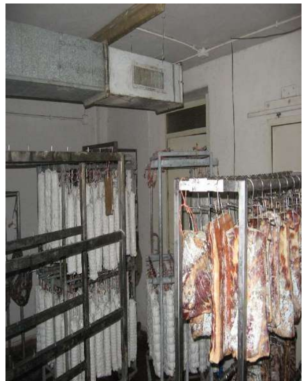
FOTOGRAFIA N° 92 Vano n° 13 – Loc. stag. ventilata
