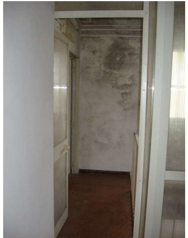
FOTOGRAFIA N°62 Vano n.33 - Disimpegno
