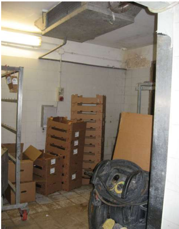
FOTOGRAFIA N° 117 Vano n° 5 Loc. Lavorazione carni-
