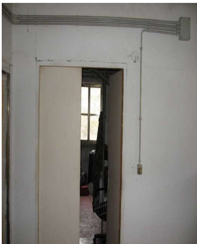
FOTOGRAFIA N° 51 Vano n° 36 – Essiccatoio
