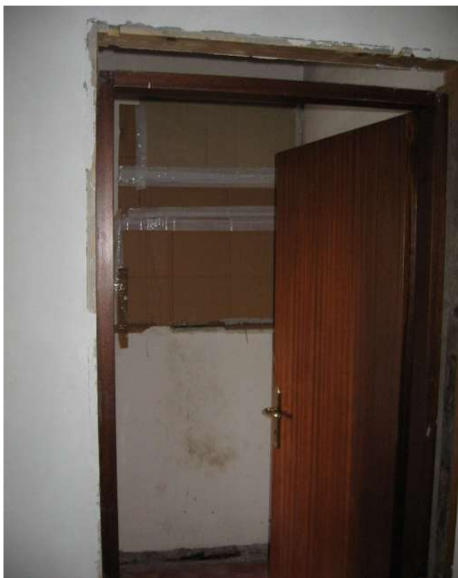
FOTOGRAFIA N° 55 Vano n° 30 – Disimpegno
