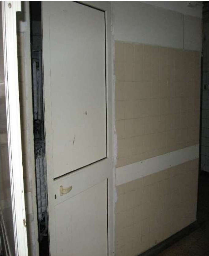
FOTOGRAFIA N° 97 Vano n° 13 – Loc. stag. ventilata
